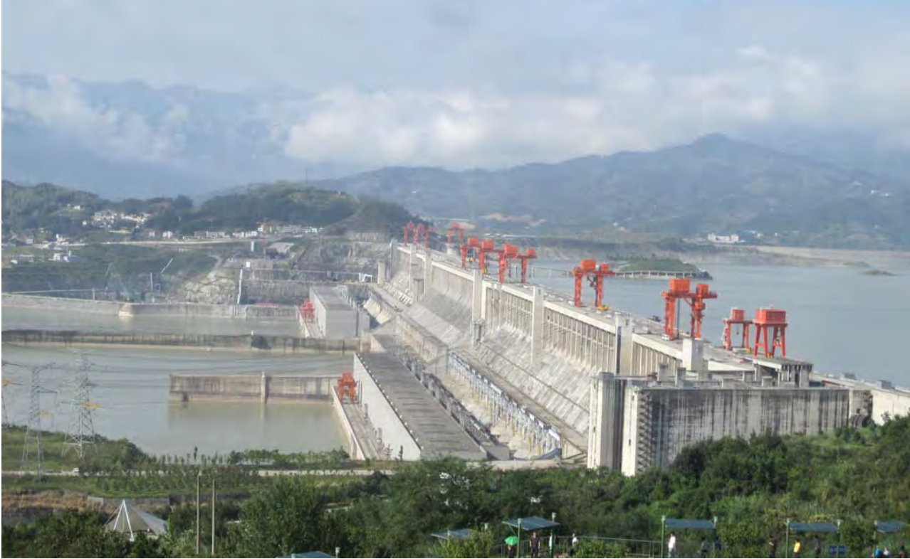
Figura 1-9. Los generadores sincrónicos trifásicos producen la mayor parte de la electricidad mundial. Esta fotografía muestra la planta hidroeléctrica de la Presa de las Tres Gargantas, situada sobre el río Yangtsé, en China. La central cuenta con 30 generadores sincrónicos trifásicos de 700 MW, cuyo peso es de 6.000.000 kg cada uno (unas 6.000 toneladas).
